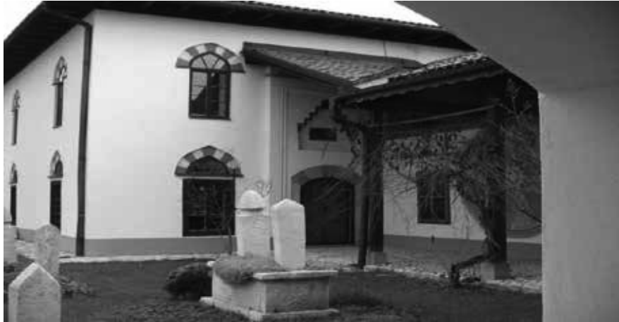
Şekil-5 Şeyh Hasan Kâimî Baba Türbesi
